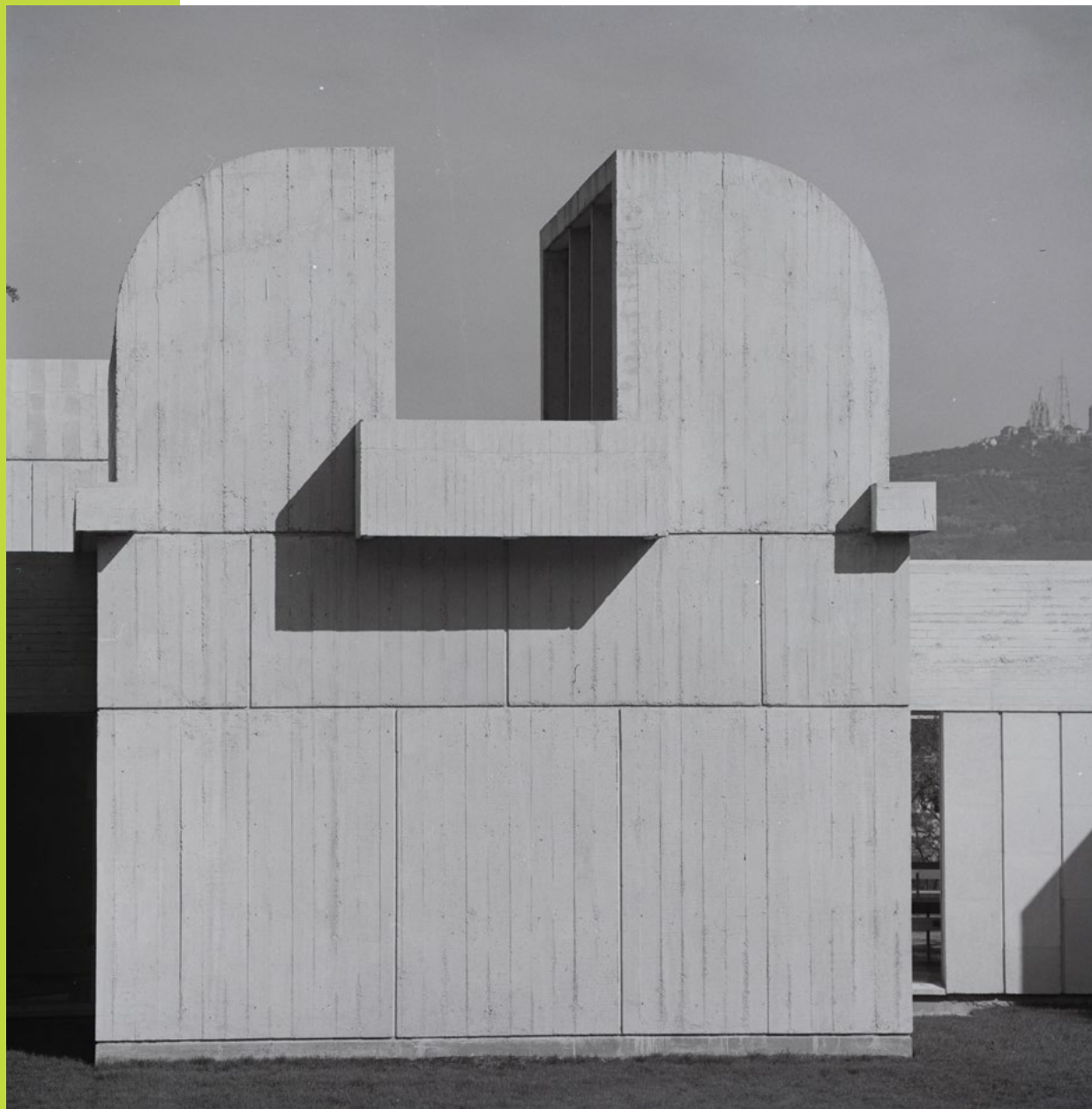
34. Francesc Català-Roca (1922-1998) , Lanterneaux de la toiture de la Fondation Joan Miró de Barcelone.
