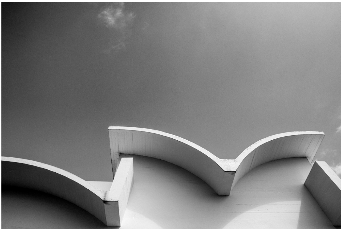
7. Lanterneaux de la toiture de l'atelier Sert.
